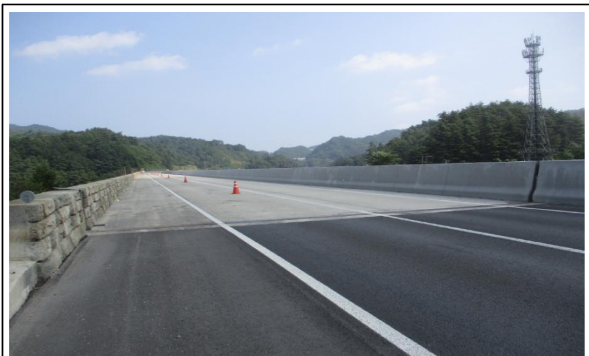
교량 상부 전경
