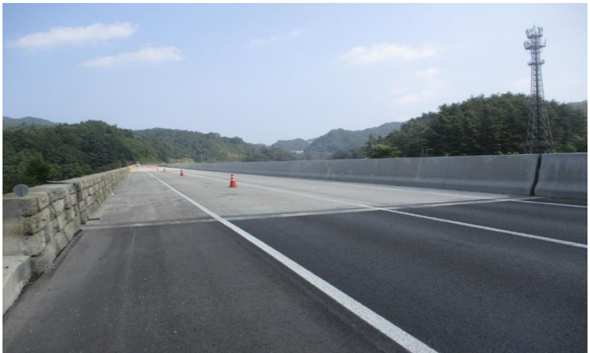
교량 상부 전경
